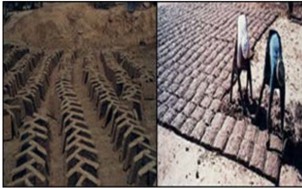
شكل (11): الطرق التقليدية لتجهيز البناء باللبن في وادي حضرموت
